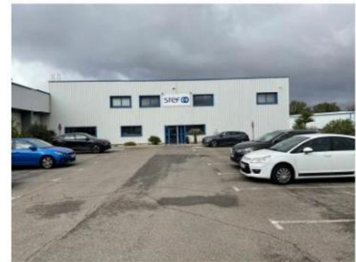
Entrée de la plateforme frigorifique
